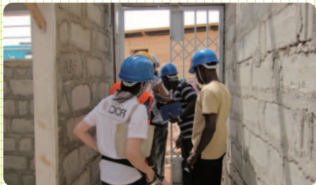
建物出入口(左向き)鉄フレームドアの強度他確認中
